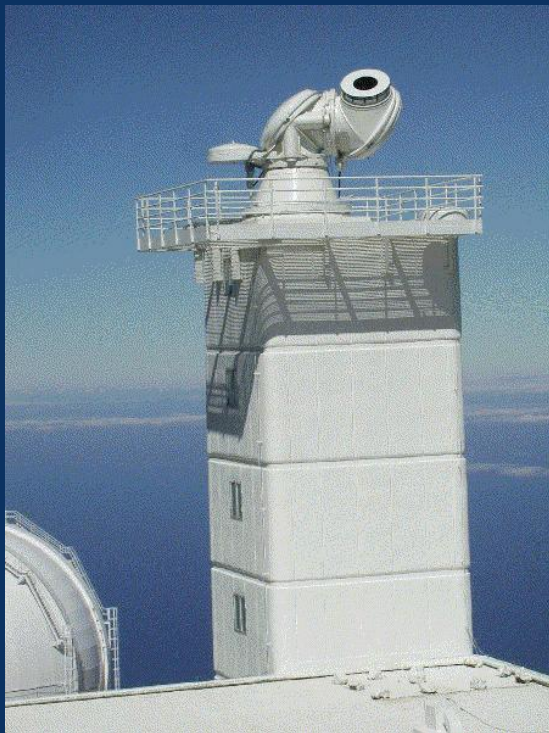
Observatório solar do instituto de física solar da Royal Swedish Academy of Sciences em La Palma/Espanha
